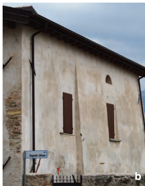
Fig. 68. Esempi di muri a scarpa aggiunti: a) MS 10, 11 e 12 (Via Zanardelli); b) MS 17 sulla parete orientale del volto in Via Romana.
