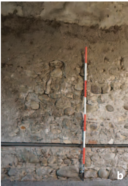
Fig. 69. Muri a scarpa su pareti di imposta di volti: a) MS 13 e b) dettaglio della tecnica muraria (Via Mazzini); c) MS 18 sul muro di imposta del volto di Via Romana.
