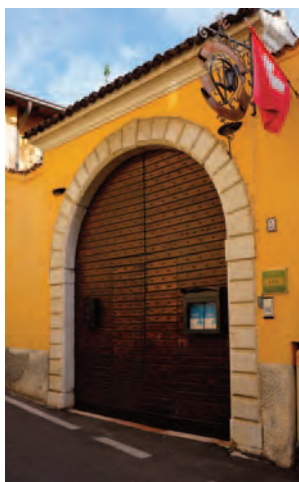
Fig. 46. Portali del tipo TP4 in Via Marconi: a) P 69 con ghiera e piedritti composti da conci singoli; b) P 77 con ghiera e piedritti composti da conci grandi lavorati a finto bugnato e incisione dell'anno 1669 in chiave.
