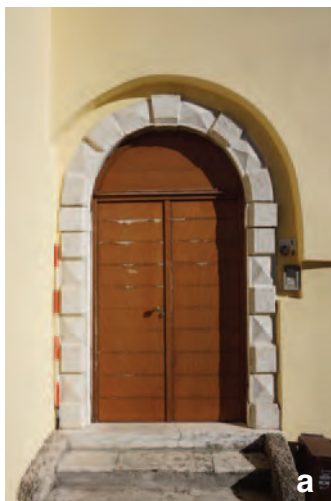
Fig. 45. Viste di a) Portale P 125 (del tipo TP2) in Via Fontanavecchia con ghiera e piedritti lapidei lavorati a falsi conci a bugnato semplice e diamantato alternati; b) portale P 37 (del tipo TP4) in Via Garibaldi con ghiera e piedritti in conci modanati e indicatore cronologico sul concio di chiave.
