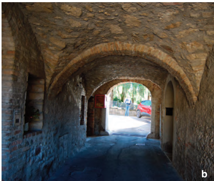
Fig. 27. Esempi del tipo TA4.1 (edifici lungo la strada che affacciano su corte posteriore, accesso da portale): a) sviluppo sul lato lungo della corte con illustrati fronte e androne per il passaggio alla corte retrostante con solaio e archi ribassati policentrici; b) sviluppo lungo il lato corto della corte con illustrati fronte e androne con volta.
