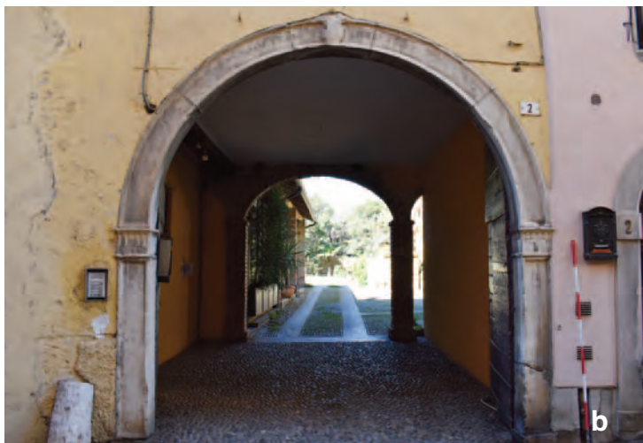
Fig. 45. Viste di a) Portale P 125 (del tipo TP2) in Via Fontanavecchia con ghiera e piedritti lapidei lavorati a falsi conci a bugnato semplice e diamantato alternati; b) portale P 37 (del tipo TP4) in Via Garibaldi con ghiera e piedritti in conci modanati e indicatore cronologico sul concio di chiave.
