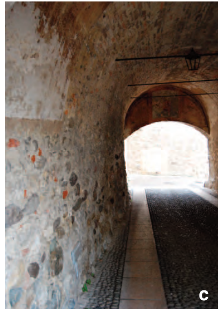
Fig. 69. Muri a scarpa su pareti di imposta di volti: a) MS 13 e b) dettaglio della tecnica muraria (Via Mazzini); c) MS 18 sul muro di imposta del volto di Via Romana.
