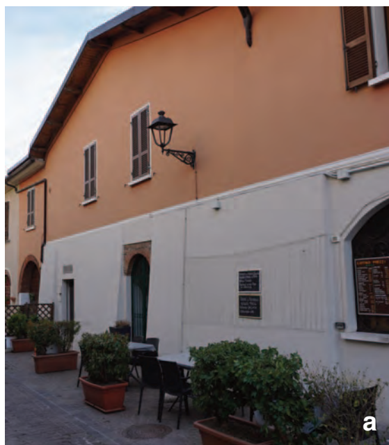
Fig. 68. Esempi di muri a scarpa aggiunti: a) MS 10, 11 e 12 (Via Zanardelli); b) MS 17 sulla parete orientale del volto in Via Romana.
