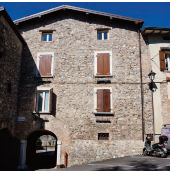
Fig. 27. Esempi del tipo TA4.1 (edifici lungo la strada che affacciano su corte posteriore, accesso da portale): a) sviluppo sul lato lungo della corte con illustrati fronte e androne per il passaggio alla corte retrostante con solaio e archi ribassati policentrici; b) sviluppo lungo il lato corto della corte con illustrati fronte e androne con volta.
