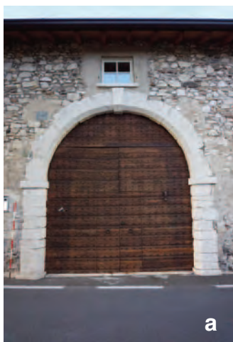
Fig. 46. Portali del tipo TP4 in Via Marconi: a) P 69 con ghiera e piedritti composti da conci singoli; b) P 77 con ghiera e piedritti composti da conci grandi lavorati a finto bugnato e incisione dell'anno 1669 in chiave.
