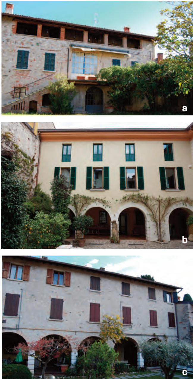
Fig. 26. Esempi del tipo a) TA2 (loggiate architravate all'ultimo piano); b), c) TA3 (portico al piano terra).
