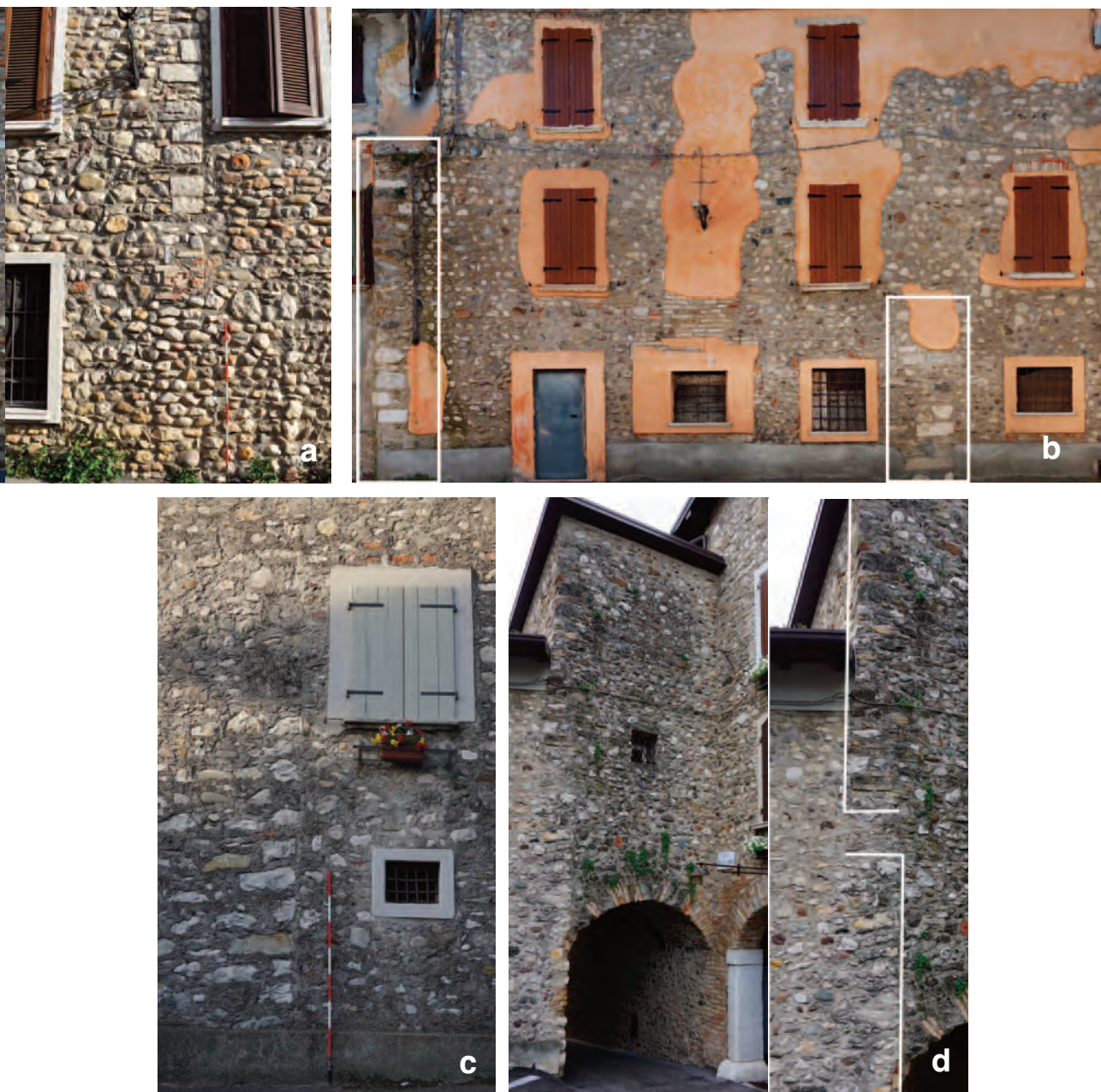
Fig. 53. Esempi di cantonali inglobati nella tessitura muraria: elementi a) C 5; b) C 8 e C 9 riquadrati in bianco (Via Garibaldi); c) C 18 in Via Marconi; d) vista e dettaglio del C 31 con innesto del volto di Via della Luna sopra all'edificio preesistente di sinistra.
