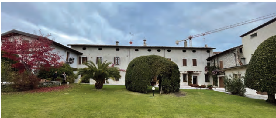
Fig. 67a. Trevignane, "casa dominicale" dei de Bernini. Prospetto sul giardino interno.
