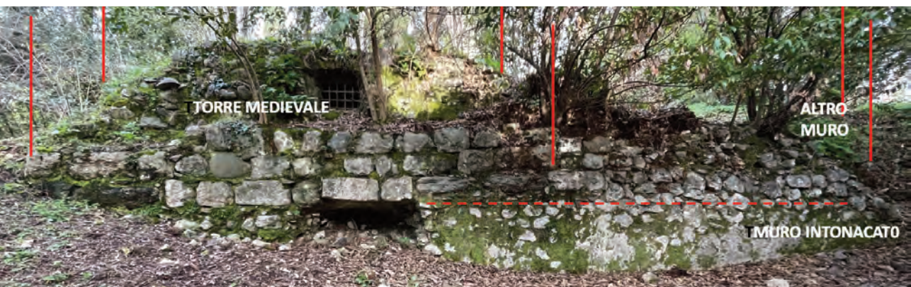
Fig. 14. Scovolo/San Fermo, torre medievale in grossi blocchi di pietra sbazzata e angolate in conci bugnati (XII-XIII secolo) impostata sul muro che delimita il bordo Sud del dosso.
