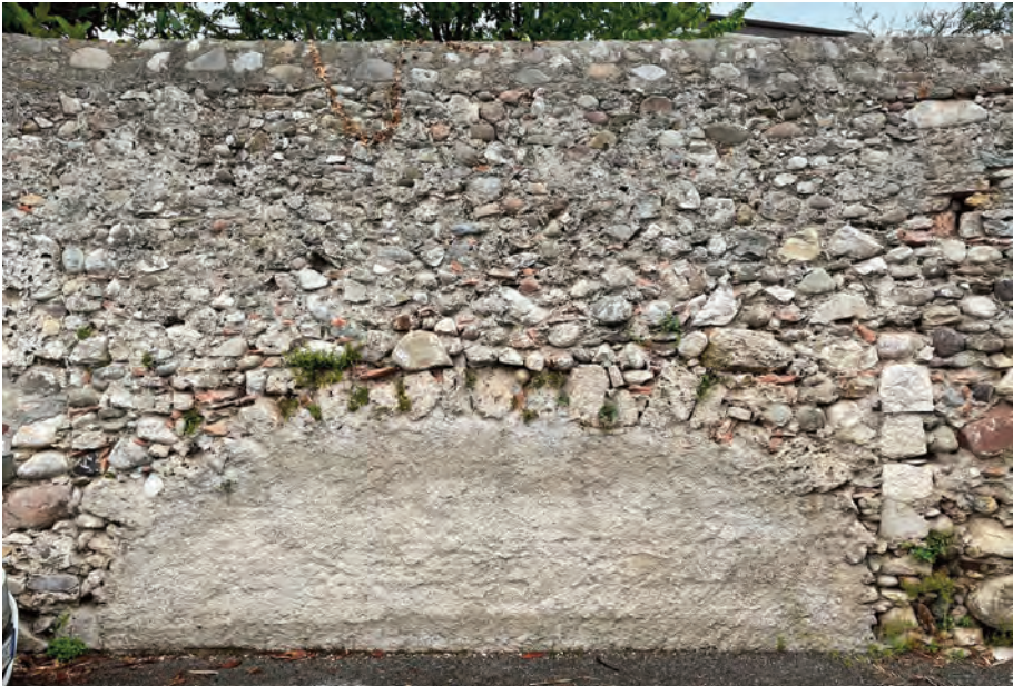
Fig. 61. Trevignane. Arco di scarico e angolata dell'edificio 3.
