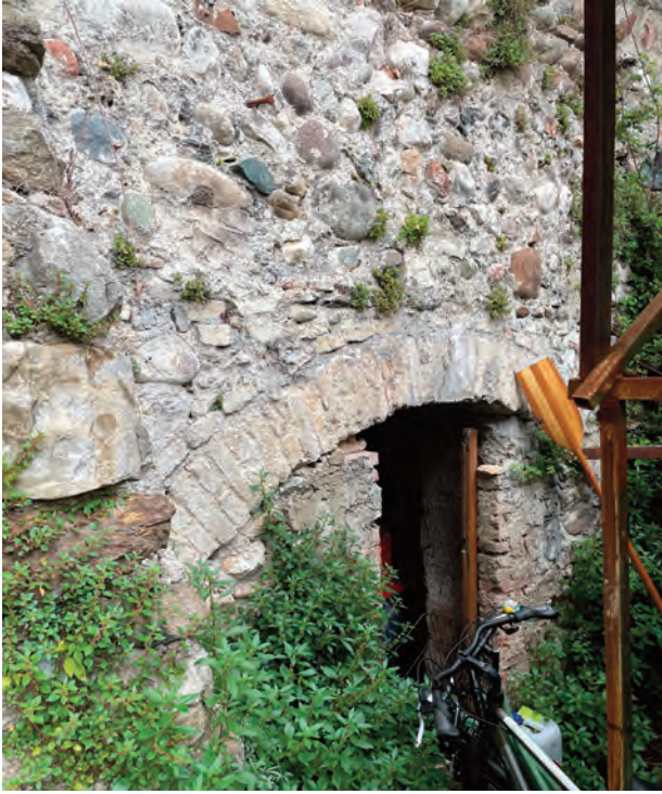
Fig. 74. Portese, ponte del castello con arco ribassato in laterizi.
