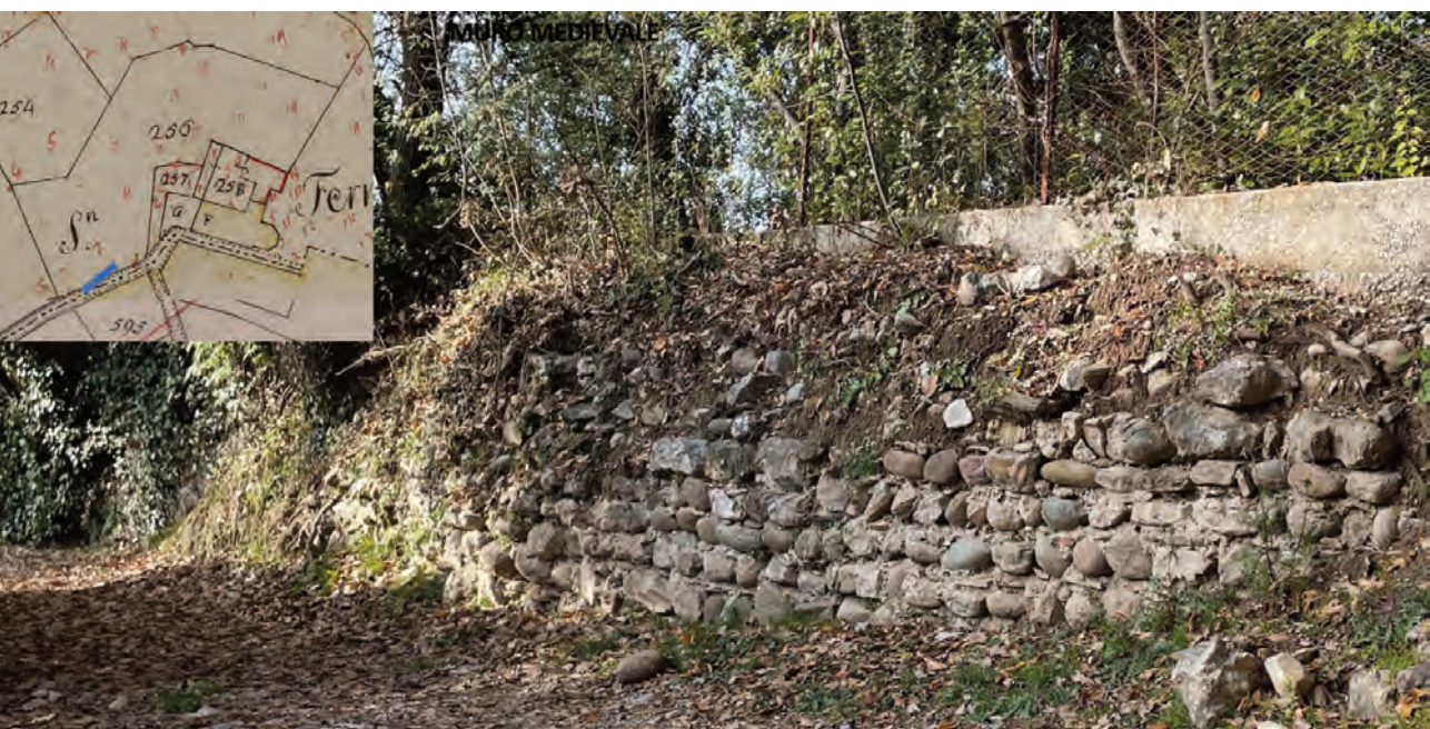
Fig. 18. Scovolo/San Fermo, perimetrale di edificio medievale affacciato sulla strada che porta alla chiesa.
