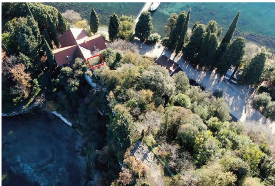
Fig. 19. Scovolo/San Fermo, edificio sul versante Est.
