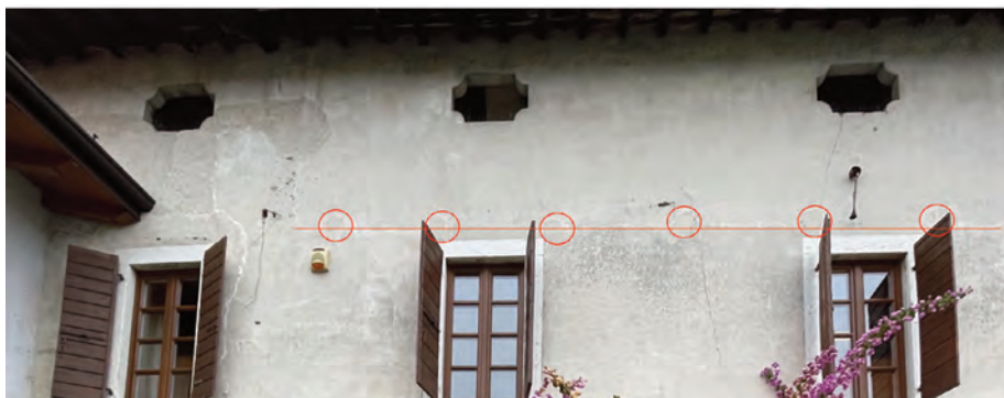
Fig. 67b. Trevignane, "casa dominicale" dei de Bernini. Prospetto sul giardino interno, sopraelevazione.
