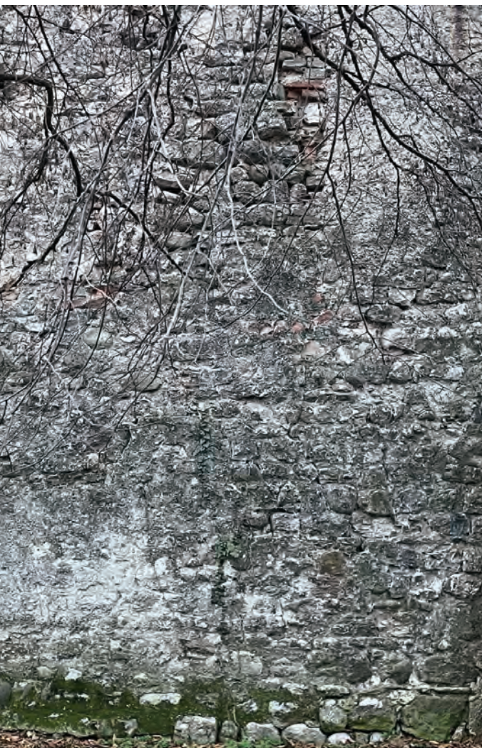
Fig. 22. San Fermo, perimetrale Nord della chiesa in prossimità della facciata.
