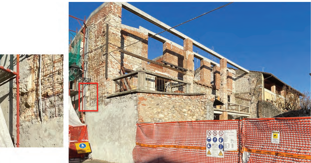
Fig. 80. Via Bertazzi 9. Angolata in pietre bugnate di un edificio in fase di ristrutturazione.
