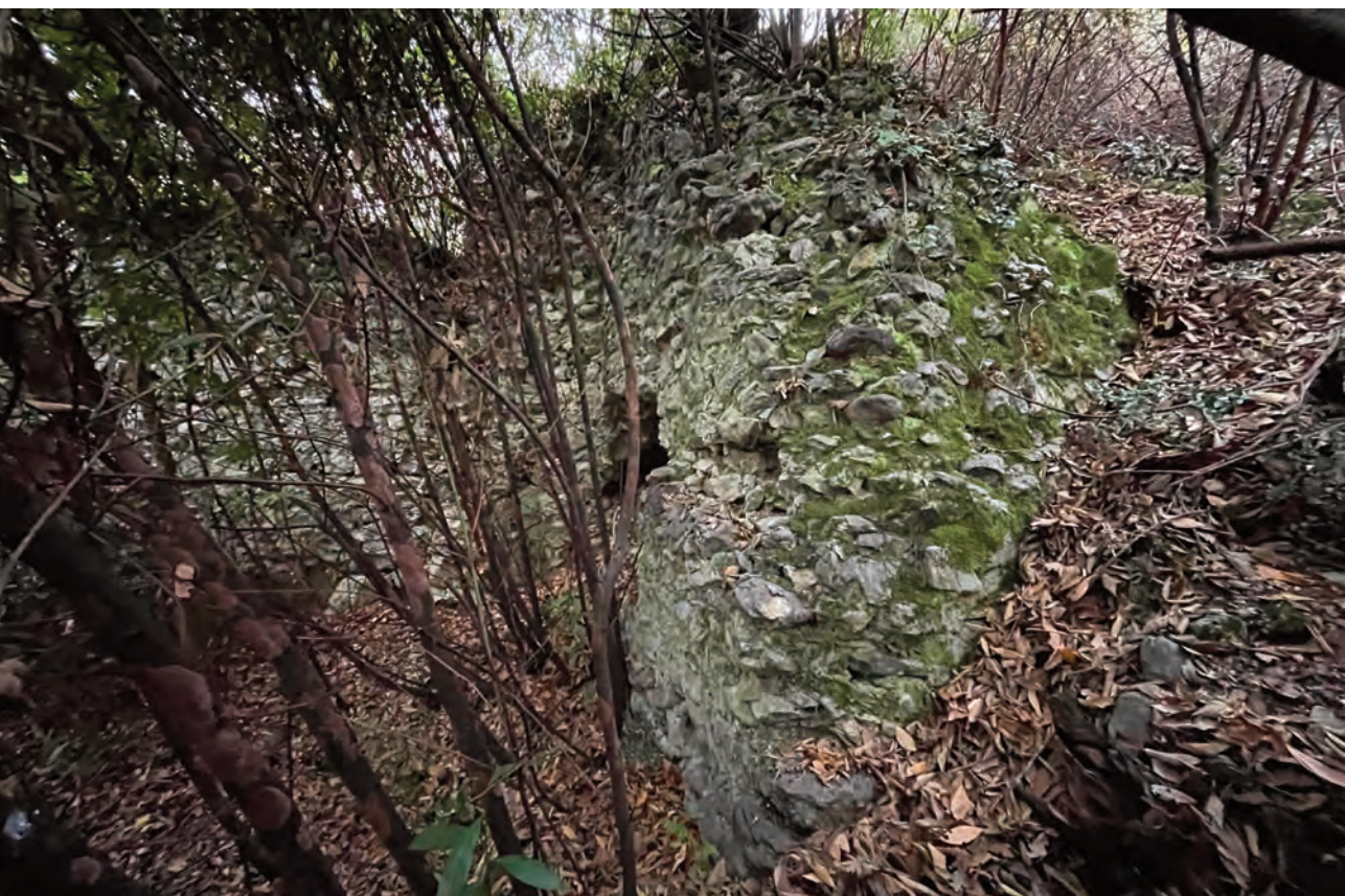
Fig. 13. Scovolo/San Fermo, pilastro e contrafforte a sostegno dell'angolata di Sud Est del muro di terrazzamento.
