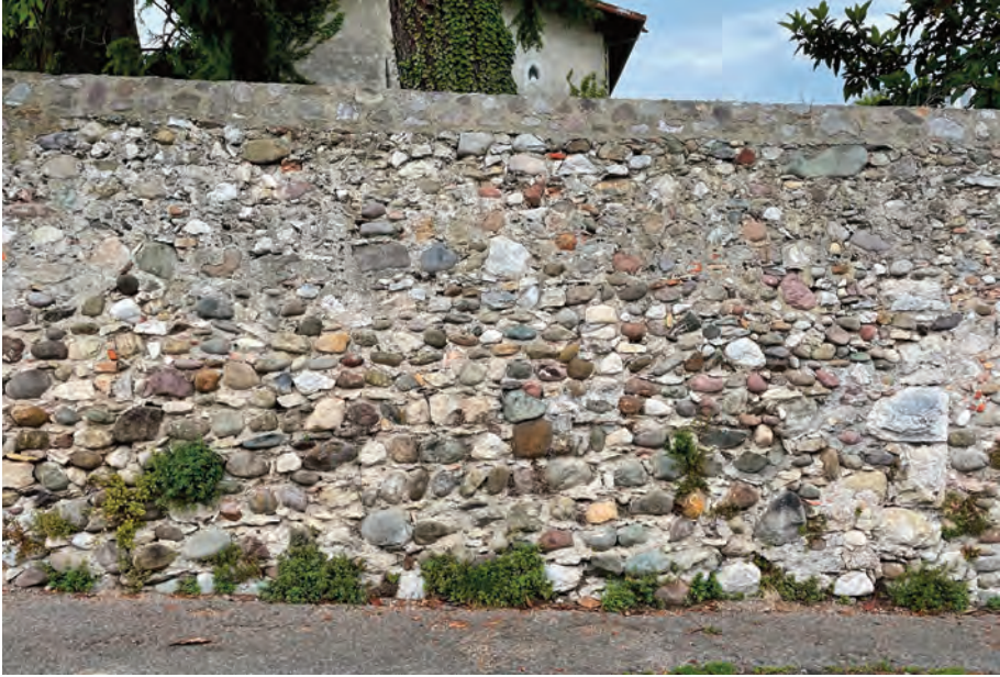
Fig. 60. Trevignane. Perimetrale dell'edificio 1.
