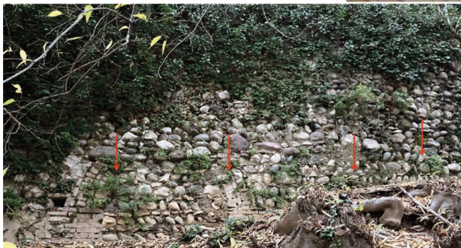
Fig. 55. Castello di San Felice, cortina est a nord della torre campanaria.
