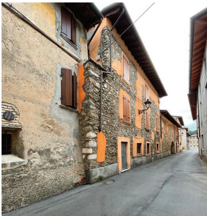
Fig. 75. San Felice, edifici medievali sul lato est di via Garibaldi.
