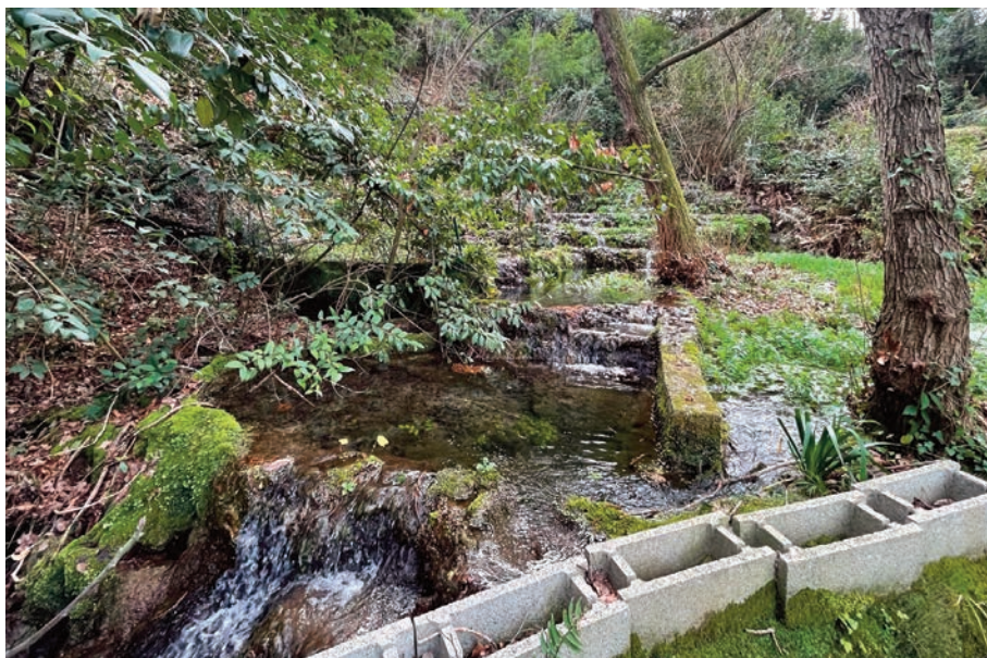
Fig. 103. Le vasche di raccolta dell'acqua a valle delle arcate.
