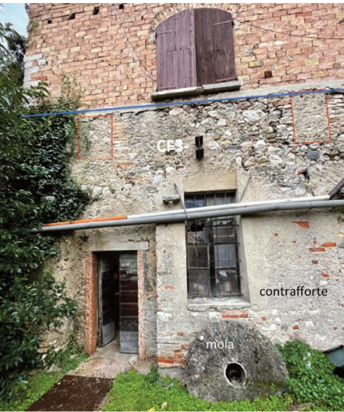
Fig. 95. Fucina, prospetto sud con CF3, provvisto di due finestre con cornice in laterizio e una porta con stipiti in pietra di scaglia rossa e architrave in arenaria sul quale è incisa la data 1454. In addosso è il contrafforte attorno alla finestra rettangolare. In primo piano la mola per il molino.
