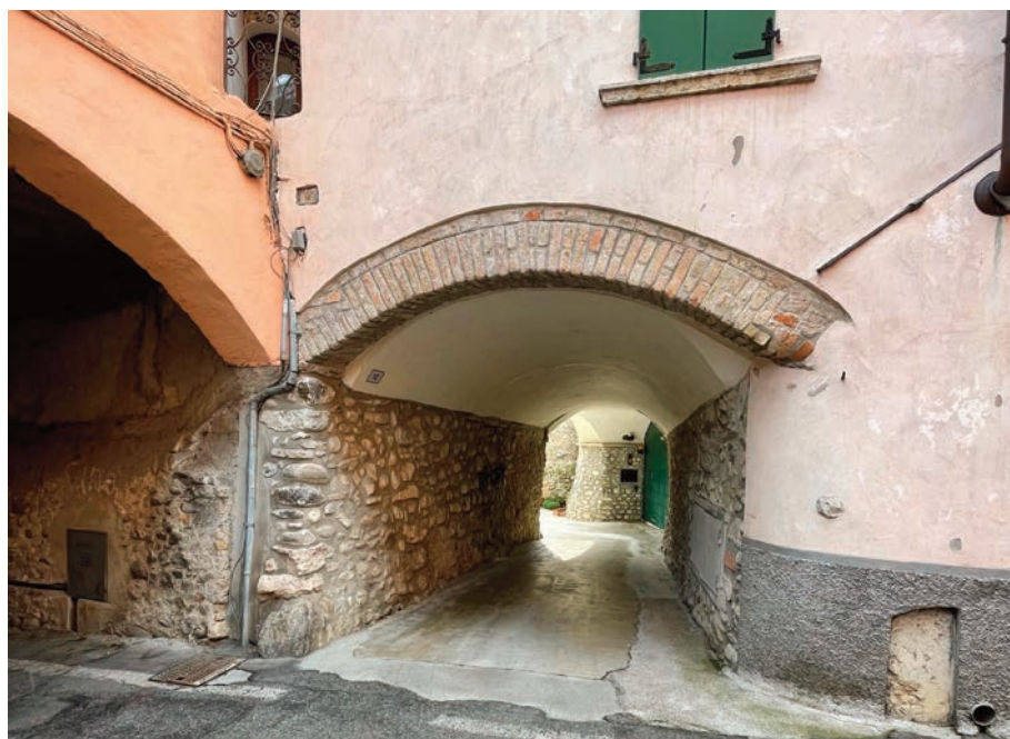
Fig. 73. San Felice, via Mazzini, portale del XV secolo con arco in laterizi provvisto di una ghiera.
