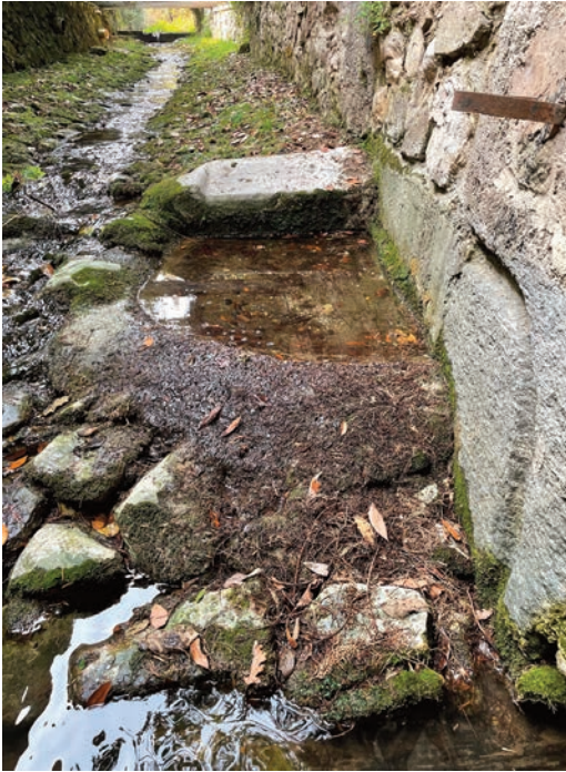
Fig. 24. Lavello a nord del ponte.
