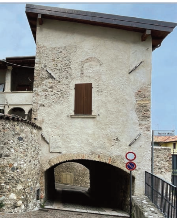
Fig. 74. San Felice, via Romana, edificio medievale a cavallo della strada.
