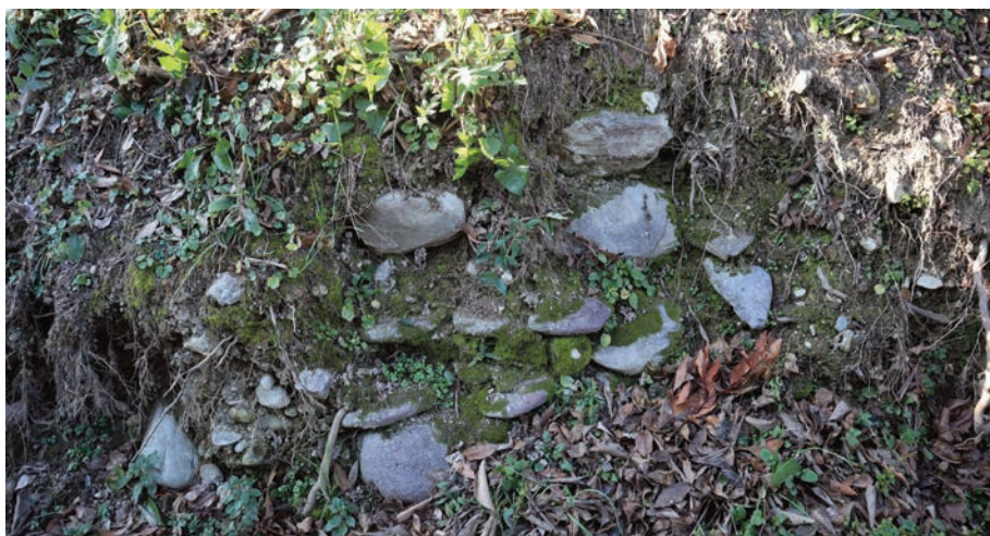
Fig. 65. San Felice, muro che si collega all'angolo nord est del castello.
