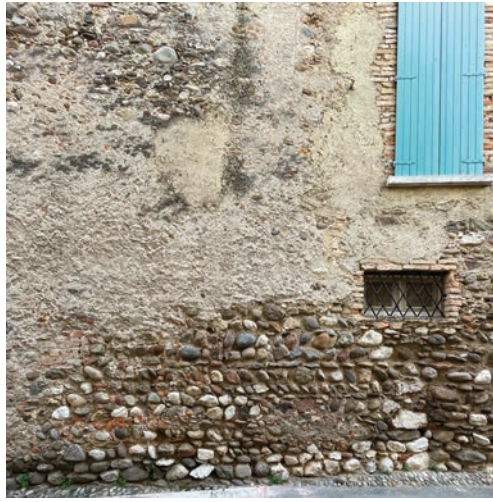
Fig. 32. Cisano, isolato a sud est del Castello (traversa di via della Chiesa). Perimetrale su strada di edificio (XIII-XIV secolo) con paramento di ciottoli in corsi orizzontali regolarizzati con zeppe e frammenti di laterizi.
