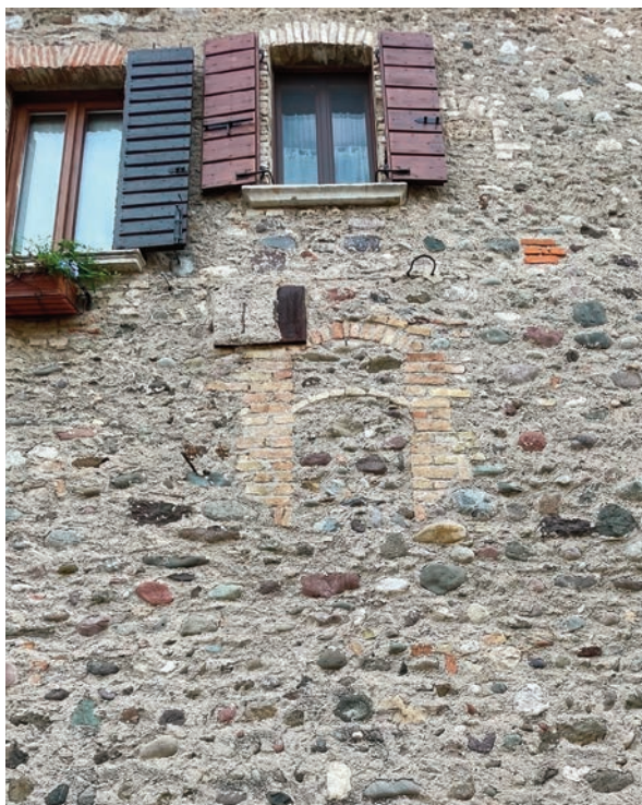
Fig. 35. Cisano, via dei Lauri, finestra con cornice in laterizi.
