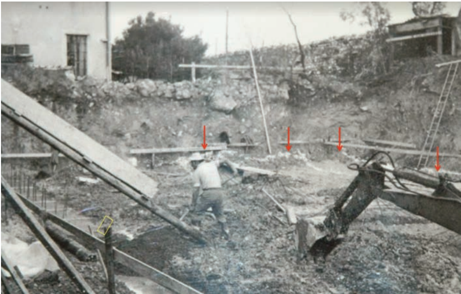
Fig. 9. Convento del Carmine, foto dello sterro per la costruzione della Casa del Pellegrino (1970-1975): strutture rinvenute e ca. tre metri di profondità e sezione dello scavo.
