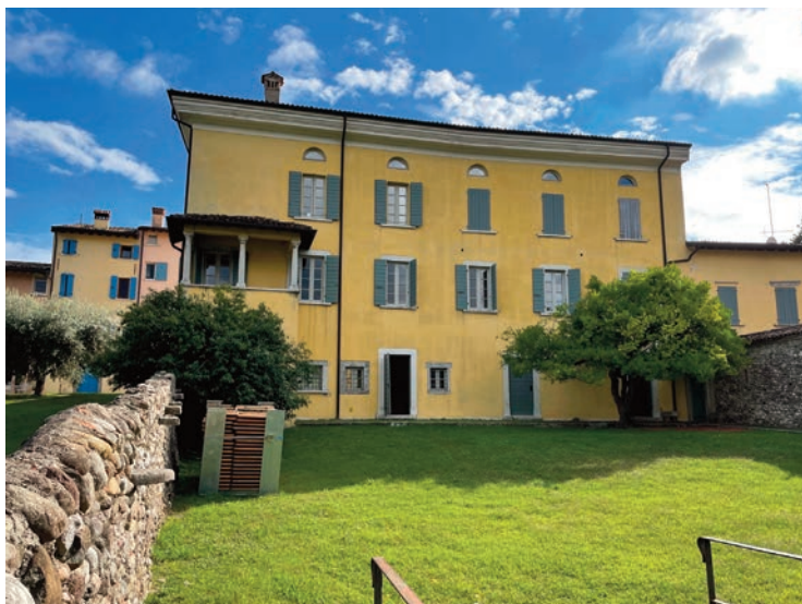
Fig. 40. Palazzo Cominelli, facciata nord.
