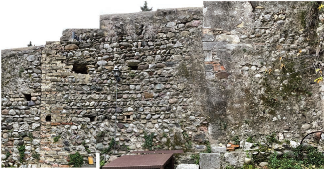
Fig. 61. Castello di San Felice, rivellino prospetto nord.
