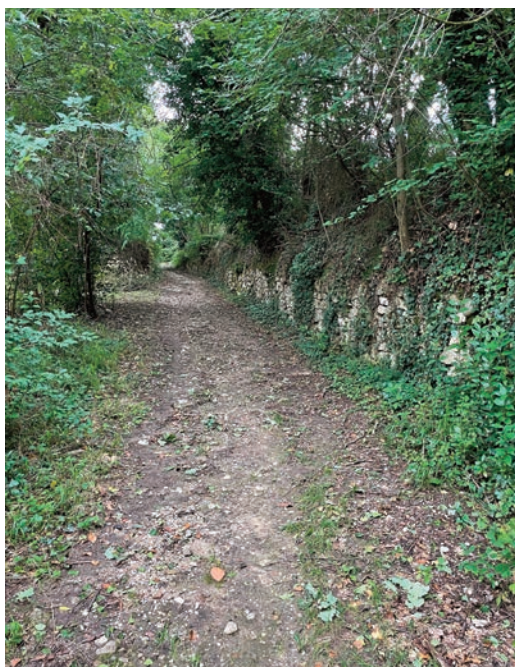
Fig. 20. Tratto di antica strada che costeggiando il versante incrociava la via Carrera proseguendo poi verso San Felice.
