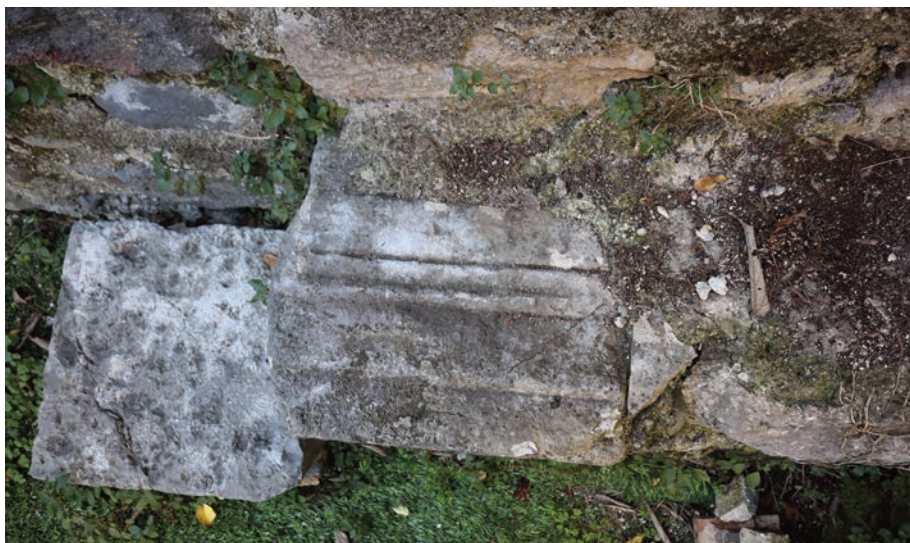
Fig. 7. Elemento architettonico di pietra grigia reimpiegato nell'angolo nord est della torre sulla porta del castello di San Felice.
