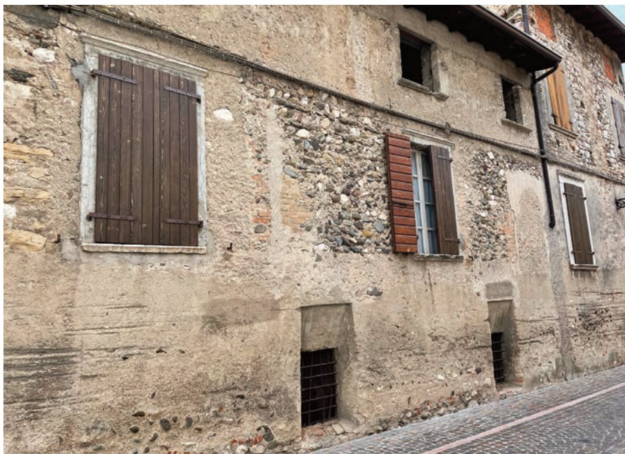
Fig. 70. San Felice, via Cavour, edificio medievale con finestre con cornici in cotto (tamponate).
