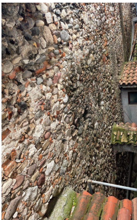
Fig. 67. San Felice, muro che delimita il cortile di un edificio su via Cavour.
