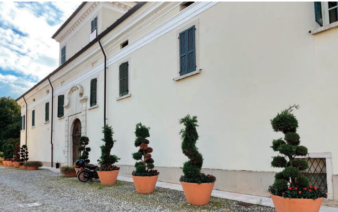
Fig. 36. Palazzo Brunati, perimetrale esterno su via Santabona.
