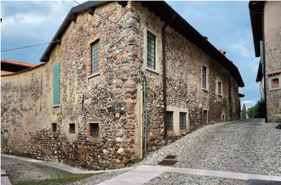
Fig. 33. Cisano, via dei Lauri/traversa di via della chiesa, edificio (XIII-XIV secolo) con paramento in corsi orizzontali di ciottoli regolarizzati con zeppe e frammenti di laterizi.
