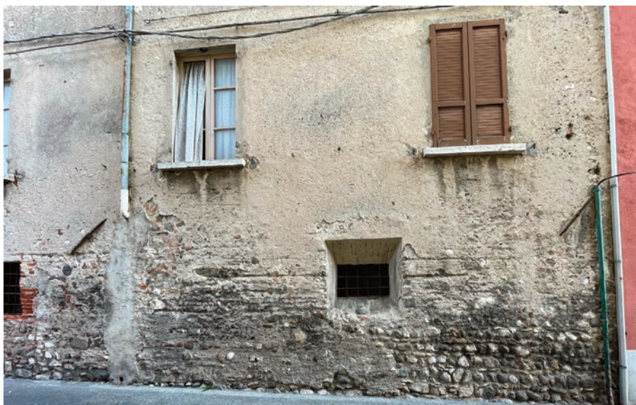
Fig. 72. San Felice, via Zanardelli. Particolare della muratura in corsi orizzontali.
