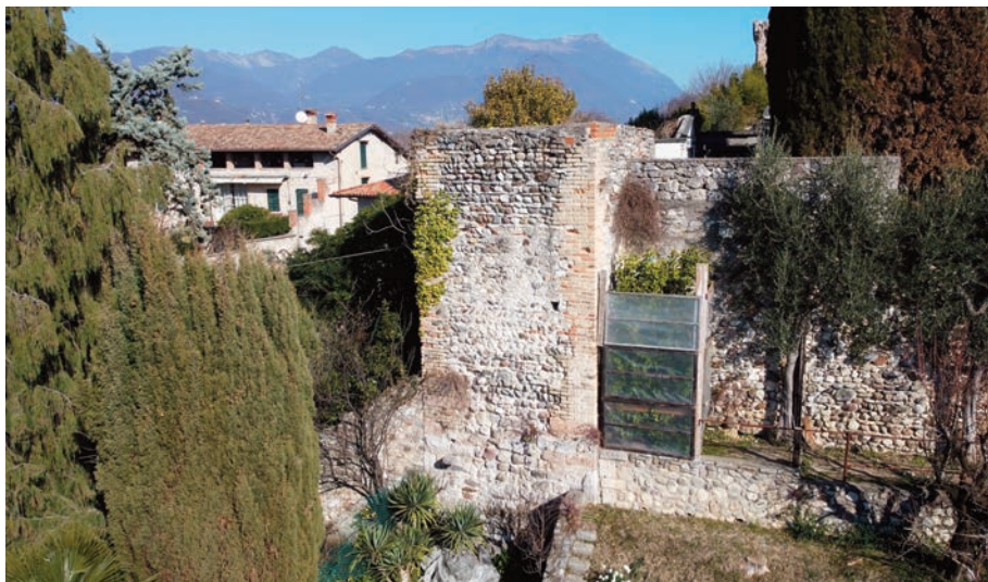
Fig. 66. San Felice, torre di sud ovest del castello alla quale, sulla sinistra, si addossa un muro.
