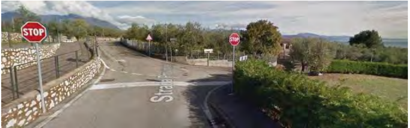
Incrocio Via Santa Maria – Via Fontanamonte
