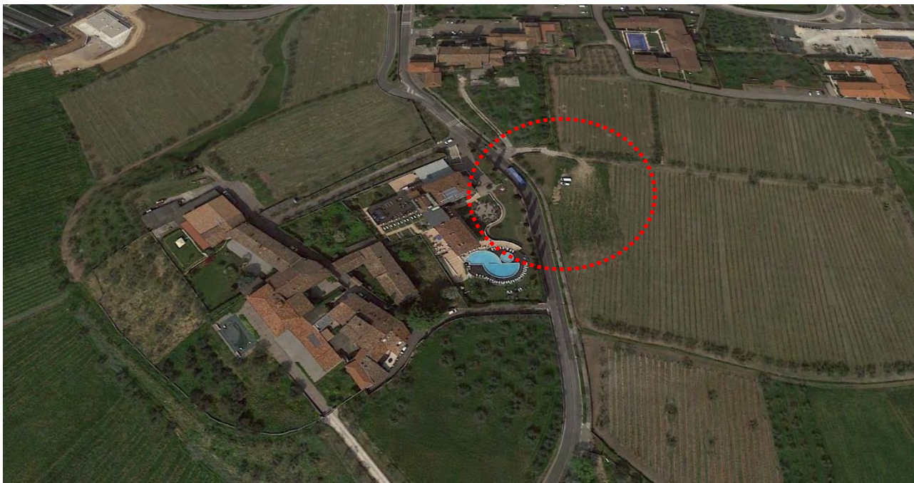
Figura 2.2.1 - Ortofoto dell'area oggetto di SUAP (Fonte: Google Earth)
